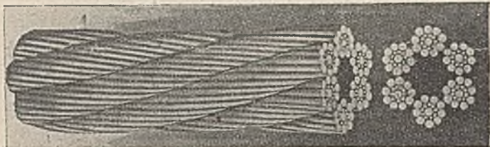
Rys. 12 a. Konstrukcja kombinowana.
