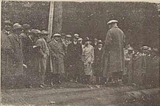
Dyr. Stocker objaśnia zebranym szczegóły montażu rygu przewoźnego.
