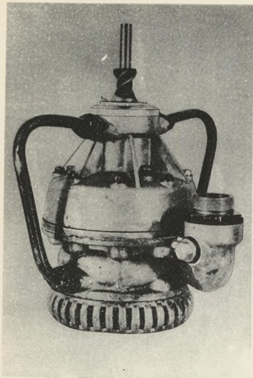
Rys. 10. Pompa wirowa z napędem od wiertarki typu WW-50
