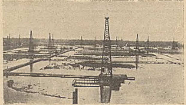
Szyb poszukiwaczy za ropą (rotacyjny) na jeziorze, F-my Vacuum Oil Co. w miejscowości Lockport.
