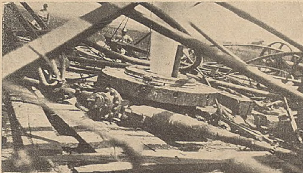
Niespodziewany silny wybuch gazu w jednej z miejscowości Gus-Coast, który zniszczył całe urządzenie.
