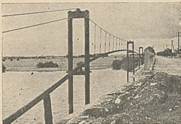
Widok mostu linowego dla gazociągu obok Rozwadowa.
