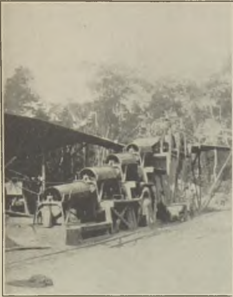
FIG. 13.—SINGLE-UNIT TROMMEL PLANT.
