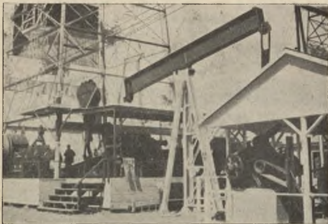
Żuraw pompowy „Emsco“, w głębi żuraw rotacyjny „Emsco“.
