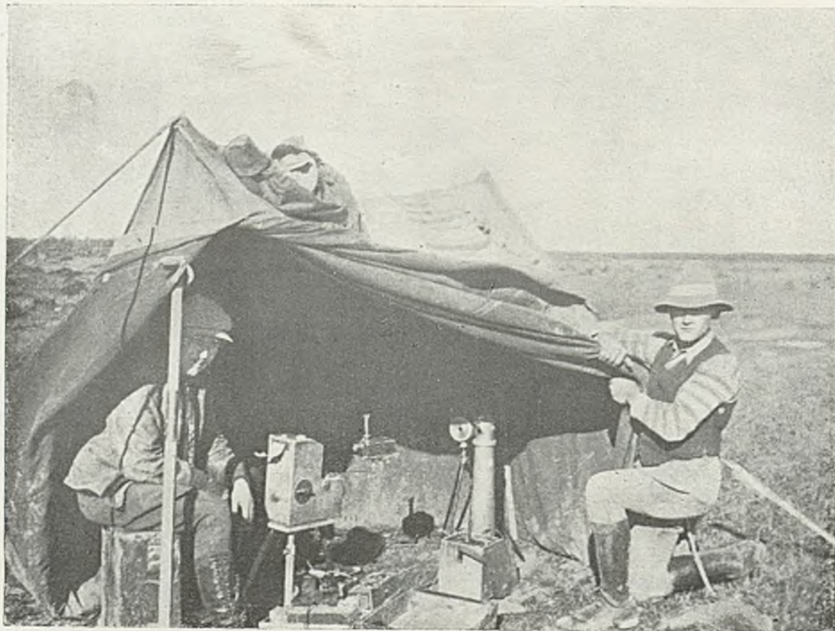
Namiot obserwacyjny wraz z przyrządami ustawionymi do odbioru sejsmogramu.
