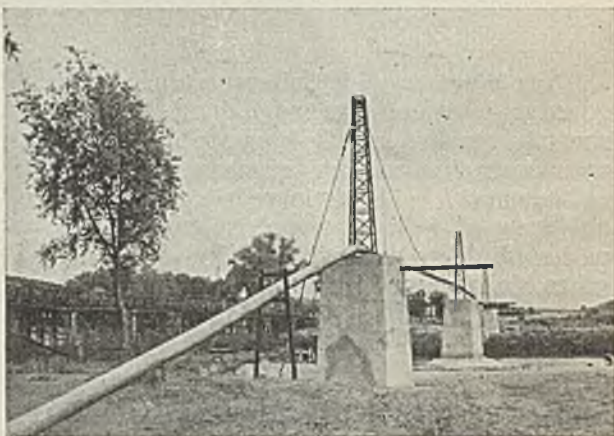
Rys. 15. Przejście gazociągu przez rzekę Wisłokę.
