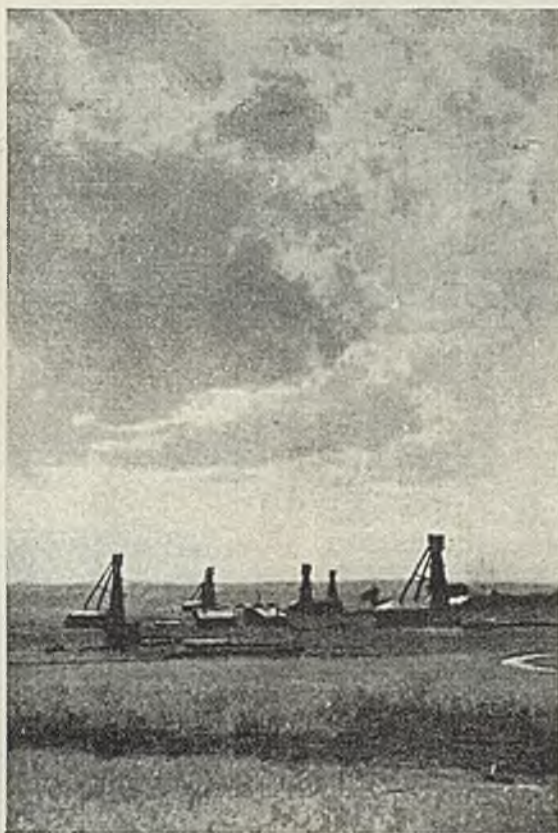
Rys. 1. Widok ogólny szypów w Roztokach.
