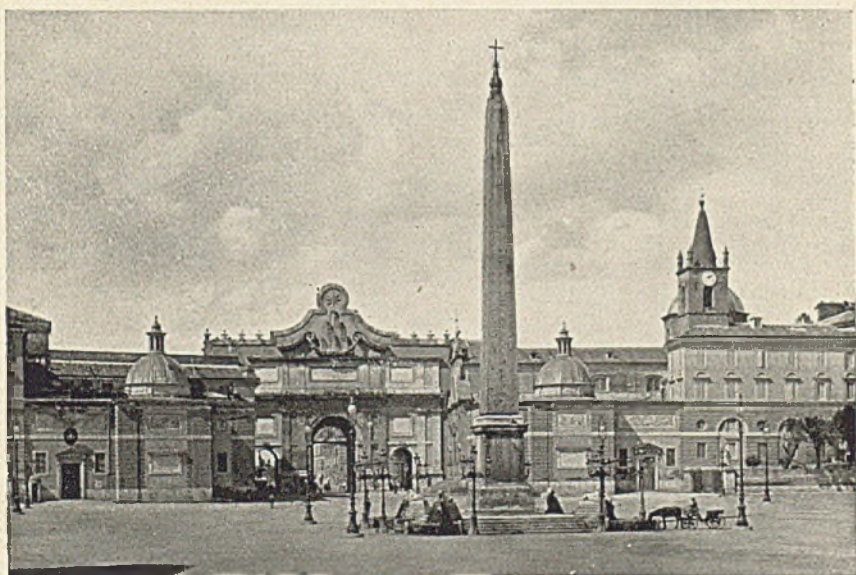
Rys. 229. RZYM. Widok placu del Popolo w stronę bramy głównej.
