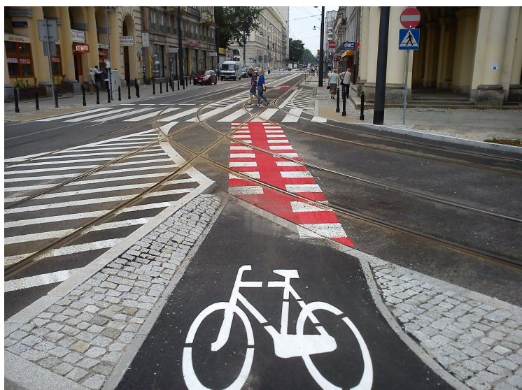
Rys. 4. Pas rowerowy na torowisku tramwajowym, ul. Nowowiejska
