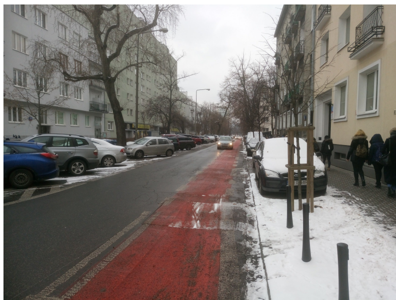
Rys. 2. Kolizyjny kontrapas, ul. Kazimierzowska Fig. 2. Contraflow non-separated bike lane, Kazimierzowska St. Źródło: Fotografia autora
