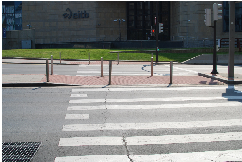
Rys. 6. Przejście dla pieszych obok stadionu San Mamés (Bilbao)
