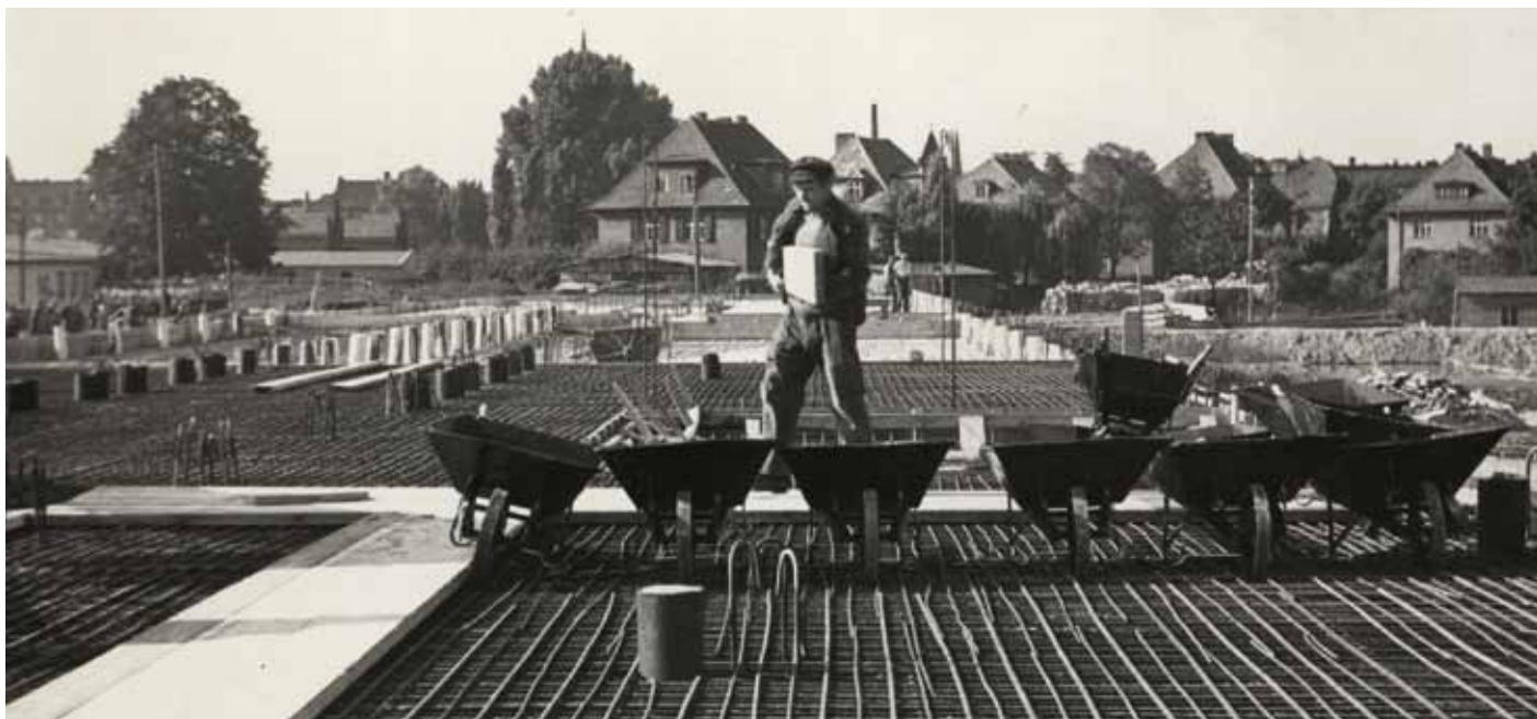
Budowa Wydziału Inżynierjno-Budowlanego, 1950 rok
