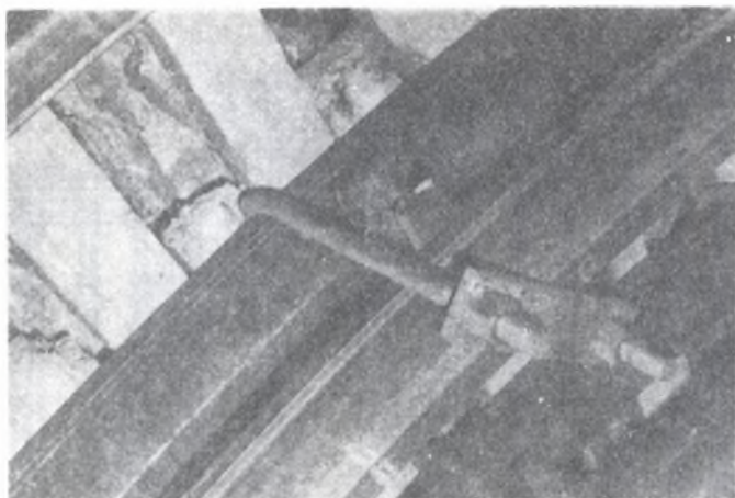
Rys. 10. Sposób połączenia odrzwi wewnętrznych z zewnętrznymi w obudowie OPPR-8/S24
