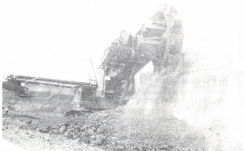
Рис. 8. Роторный экскаватор С700 в процессе выемки породы на РК "Езеро" шахты железной руды "Любля"
