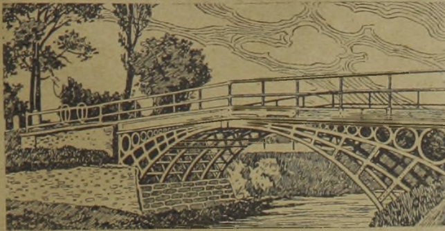
Brücke über das Striegauer Wasser bei Laasan i. Schl. (erbaut 1794).
