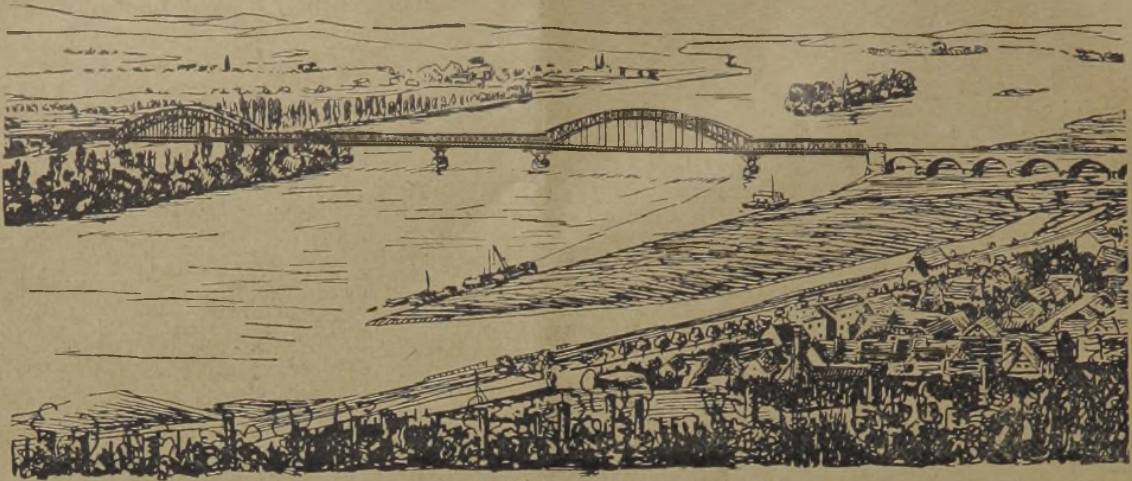
Rheinbrücke bei Rudesheim (M. A. N.)
