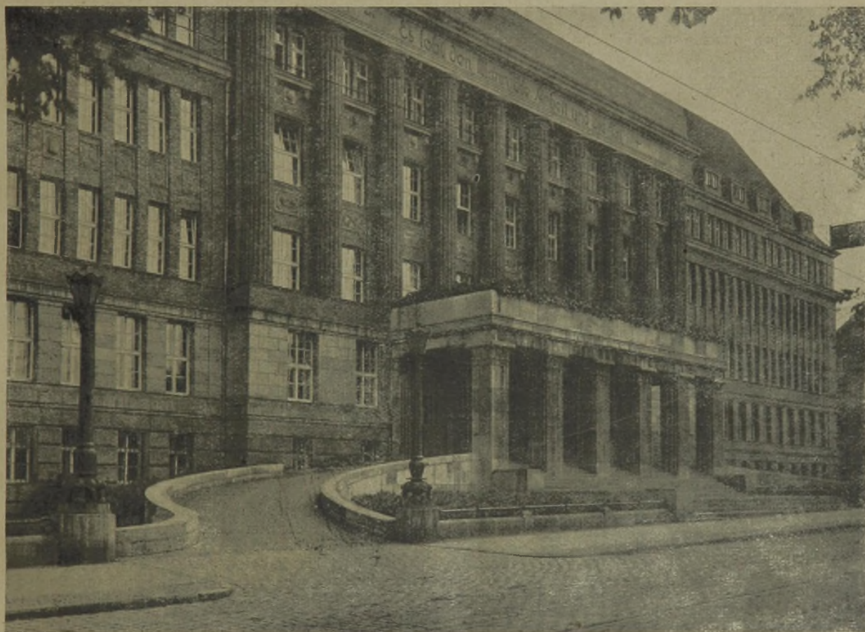
Verwaltungsgebäude der „Dortmunder Union“.
