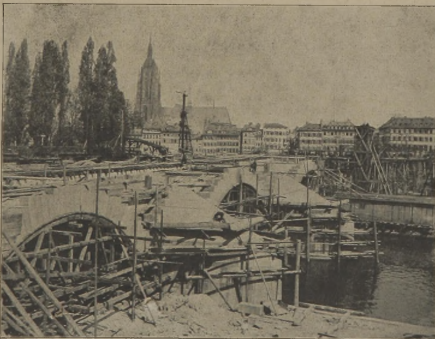
Frankfurt. — Mainbrücke im Bau
