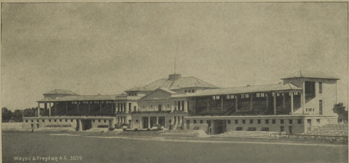
Verwaltungs- und Tribünengebäude im Stadion Frankfurt a. M. Ausführung: Wayß & Freytag A. G.
