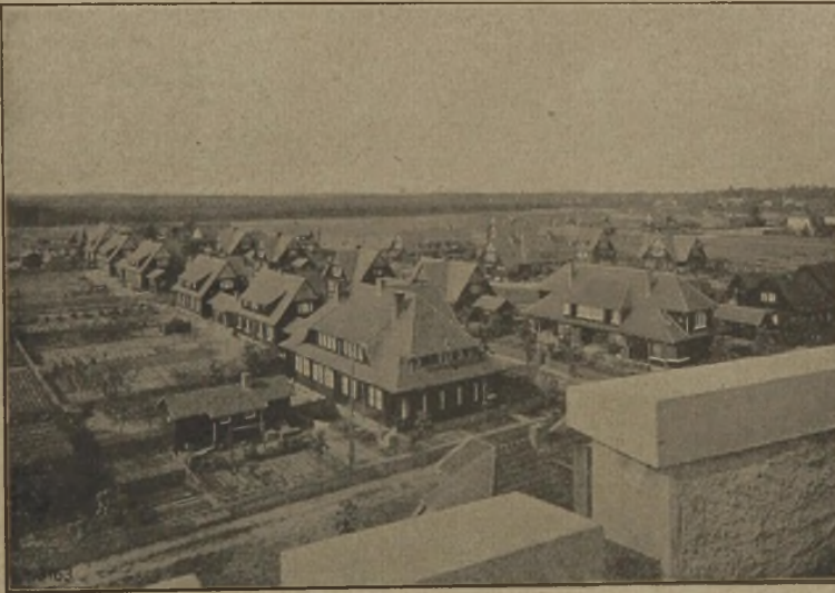
Teilansicht der Holzhaussiedlung Neu-Oedernitz bei Niesky
