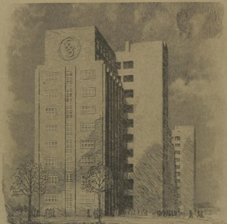
Das neue Schaltwerk der Siemens-Schuckertwerke in Berlin-Siemensstadt
