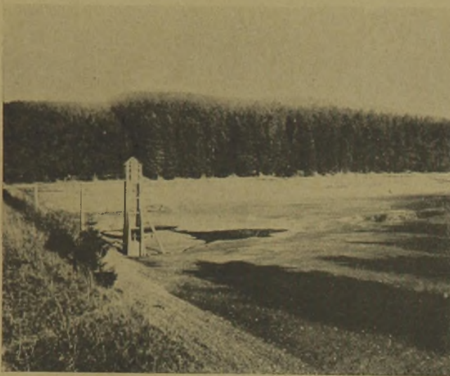
Bild 6. Oberharzer Teich mit Striegelhäuschen in entleertem Zustand
