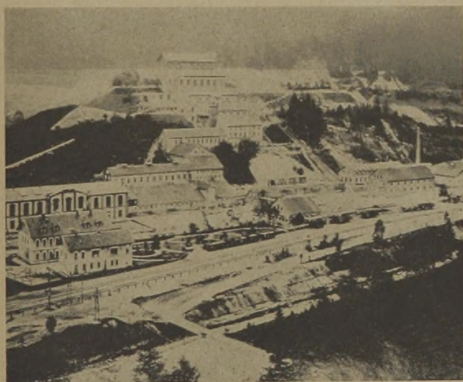
Bild 9. Aufbereitungsanlage in Lautenthal
