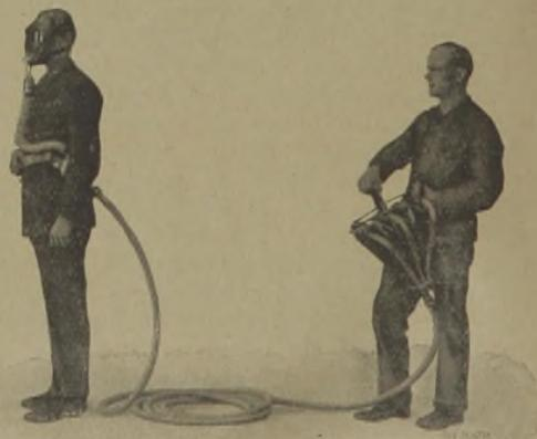
Abb. 7. Druckschlauchgerät mit Handblasebalg. Schlauchlänge bis zu 30 m. Kann auch mit Atemmundstück verwendet werden
