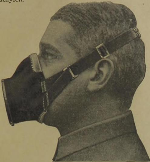
Abb. 1. Halbmaske mit Staubfilter. Segeltuchkörper. Keine Atemventile. Leichtes Gewicht, geringe Belästigung beim Tragen
