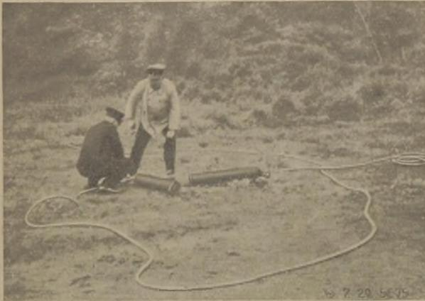
Abb. 11. Frischluftversorgung für die in Abb. 10 dargestellte Arbeitsgruppe. Schlauchlänge bis zu 200 m
