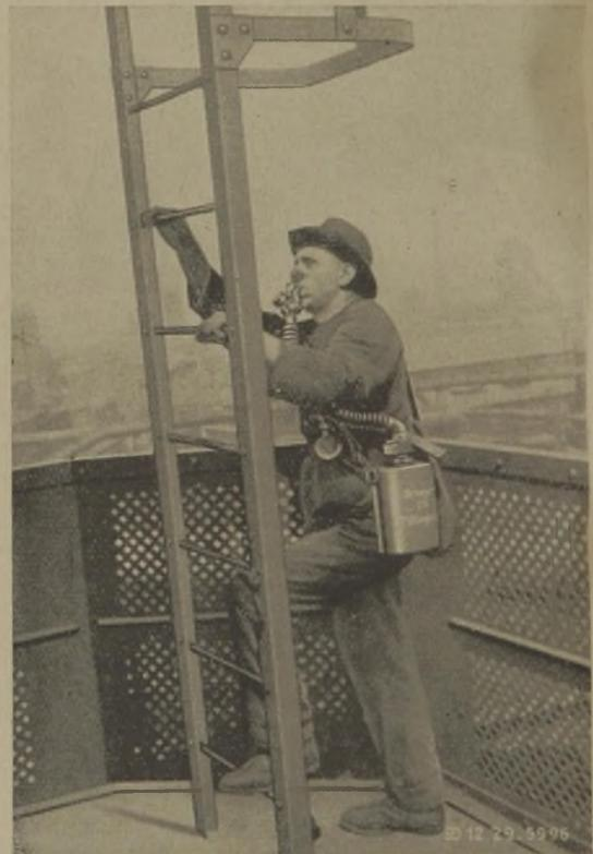
Abb. 4. Kohlenoxyd-Filtergerät mit Atemmundstück. Verwendbar auch mit Vollmaske
