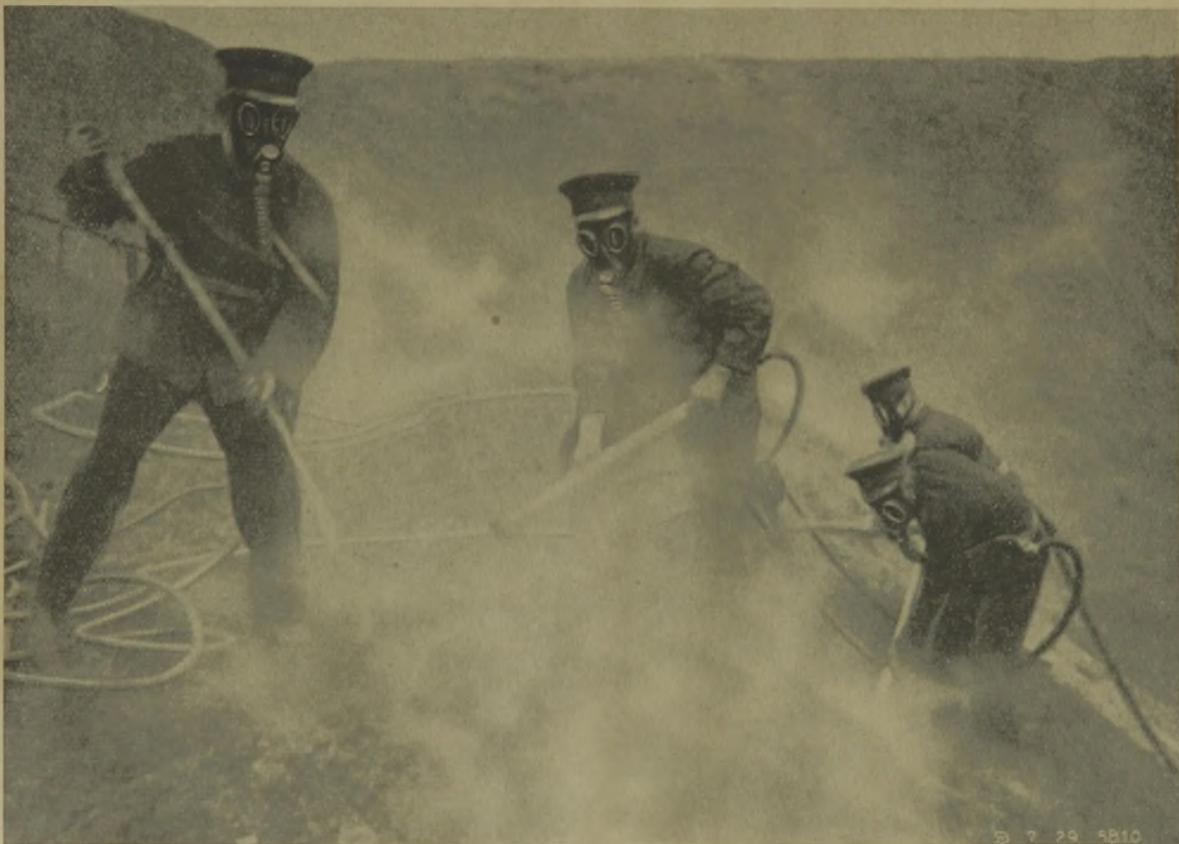
Abb. 10. Injektor-Schlauchgerät in Verbindung mit Vollmaske, verwendet bei einem Berghaldenbrand
