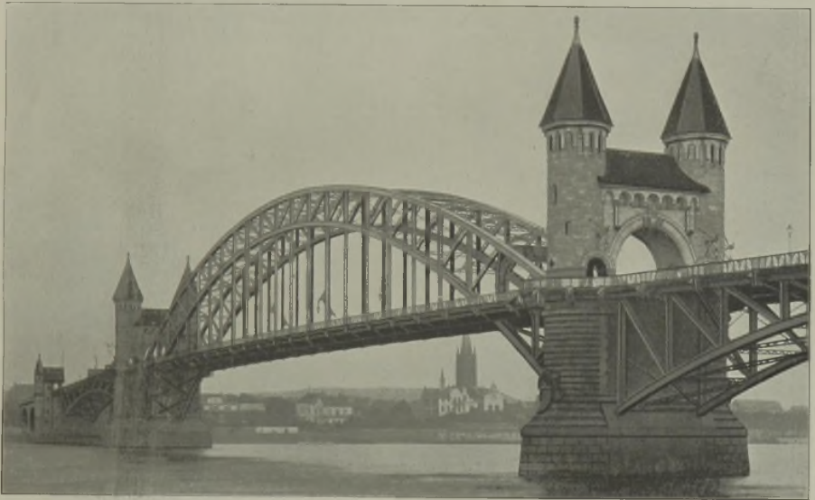
Fig. 24. Rheinbrücke in Bonn (Dreieckstil, Mittelloffnung deutscher Bogen, Seitenöffnungen Zwickelträger).
