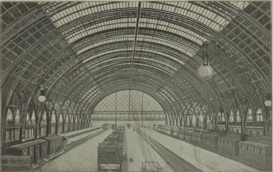
Fig. 33. Halle des Altstädter Bahnhofes in Dresden (Netzwerkstil)
