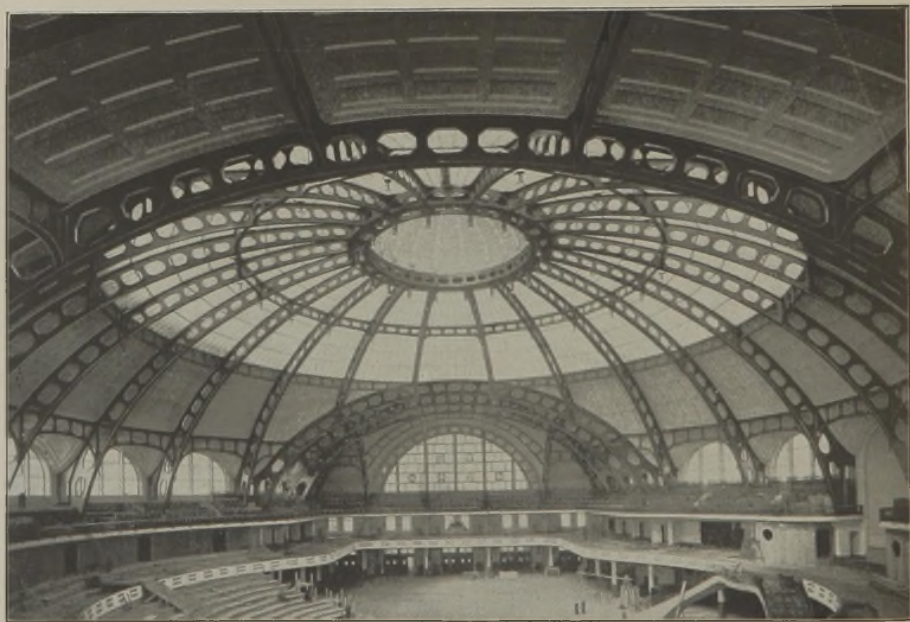
Fig. 35. Festhalle in Frankfurt a. M. (Vierendeelstil).
