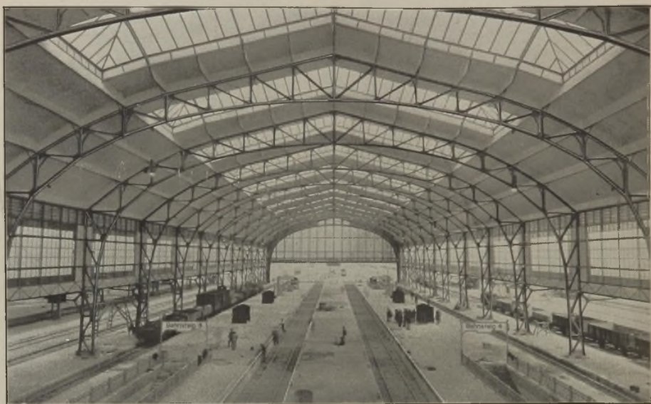
Fig. 34. Bahnhofshalle in Metz (Dreieckstil).
