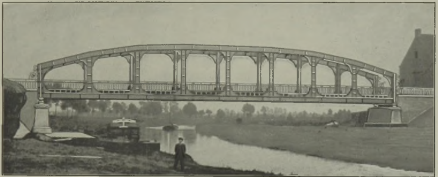
Fig. 29. Straßenbrücke über die Lys bei Ousselghem (Vierendeelstil, Halbparabelträger).
