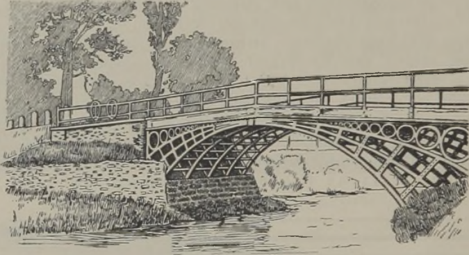
Fig. 8. Brücke über das Striegauer Wasser bei Laasan.
