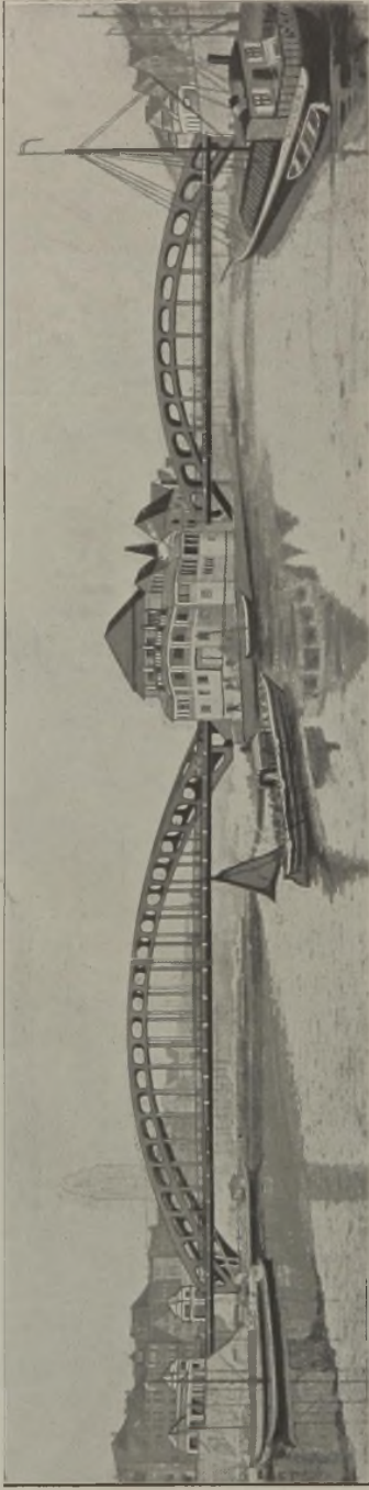
Fig. 30. Entwurf für die Kaiserbrücke in Bremen (Vierendeelstil, deutscher Bogen).
