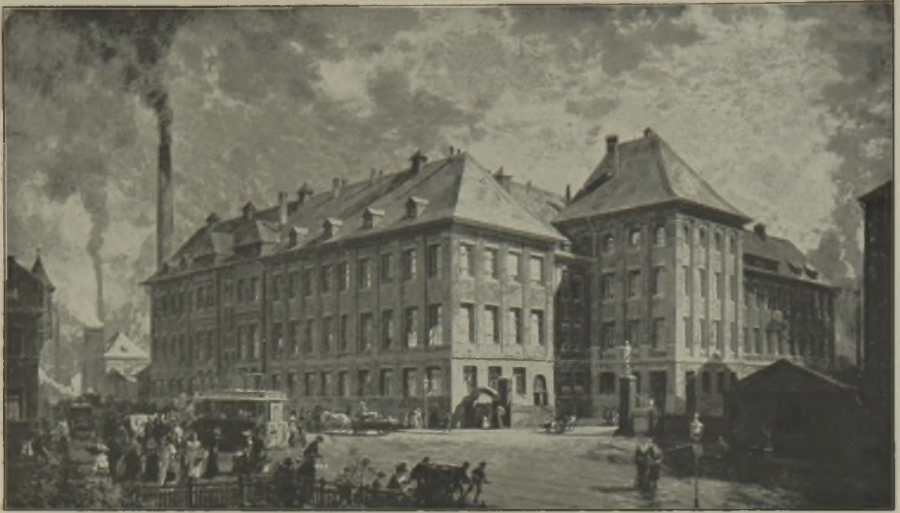
Abb. 1. Gesamtansicht des Gebäudes der chemisch-physikalischen Versuchsanstalt der Gußstahlfabrik in Essen. Bebaute Grundfläche 3635 qm, in fünf Geschossen sind in Nutzräumen und Fluren über 11 000 qm Grundfläche vorhanden.
