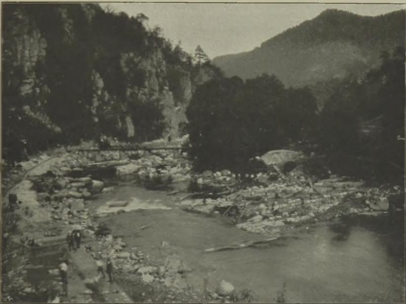
Fig. 2. Wehr und Obergraben im Bau.
