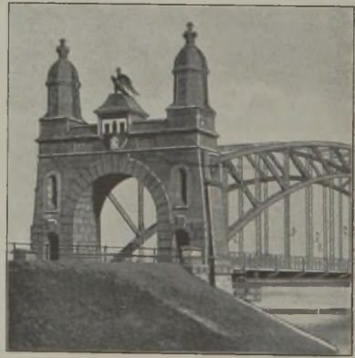
Fig. 6. Straßenbrücke über die Süderelbe bei Harburg 1899.
