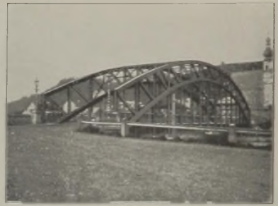
Fig. 25. Straßenbrücke über die Alz bei Trostberg.
