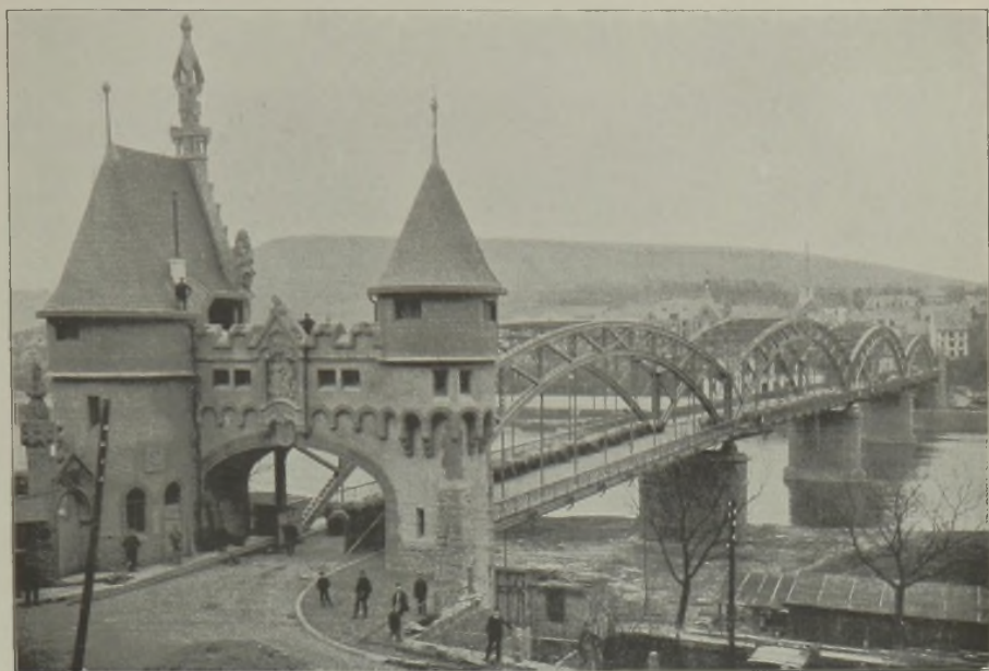
Fig. 10. Straßenbrücke über die Mosel bei Trarbach-Traben 1899.
