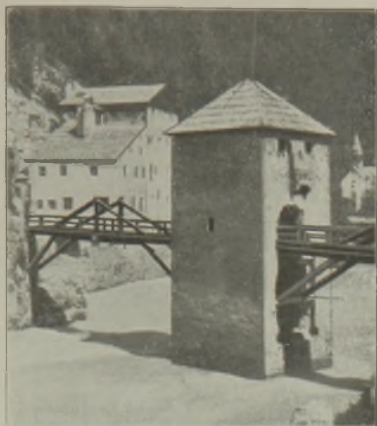
Fig. 16. Kleine Holzbrücke mit Turm bei Altfinstermünz (Tirol).
