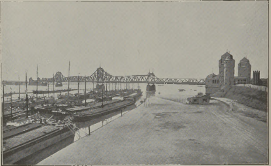
Fig. 19. Straßenbrücke über den Rhein bei Ruhrort-Homberg. (Eisenkonstruktion von Maschinenfabrik Augsburg-Nürnberg A.-G., Werk Gustavsburg)
