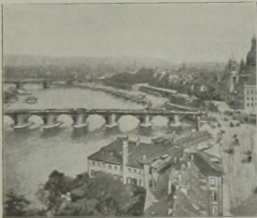
Fig. 22. Die alte Augustus-Brücke über die Elbe in Dresden. (Vor kurzem abgebrochen)
