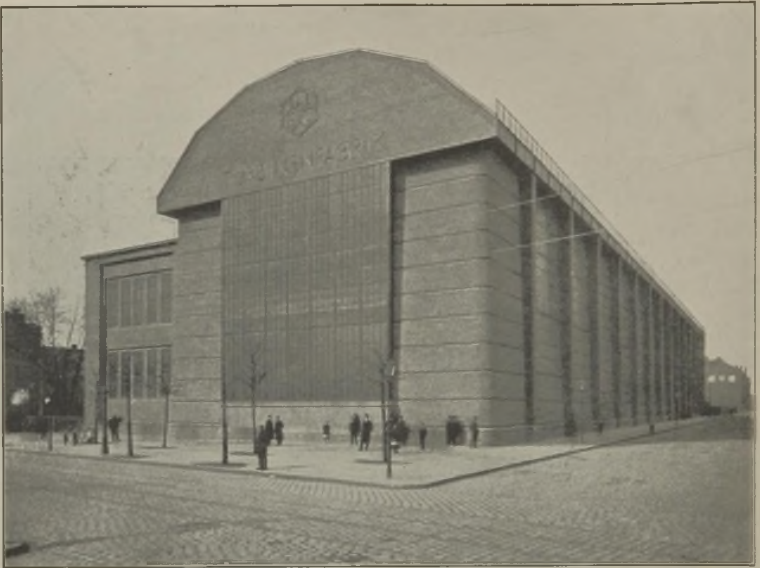
Fig. 8. Eisenbetonbau der Dampfturbinenfabrik der AEG in Berlin von Prof. P. Behrens.
