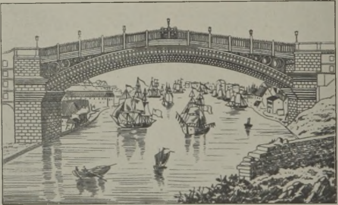
Fig. 5. Gußeiserne Brücke über den Wear-Fluß 1796.
