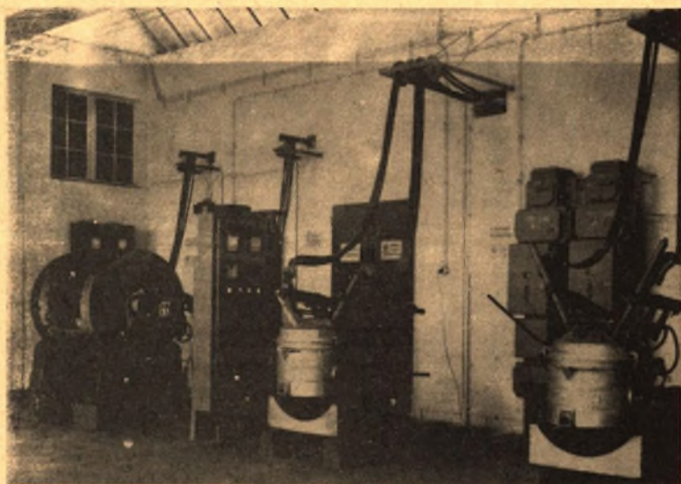
Rys. 14. Elektryczne piece do topienia w hali doświadczalnej
