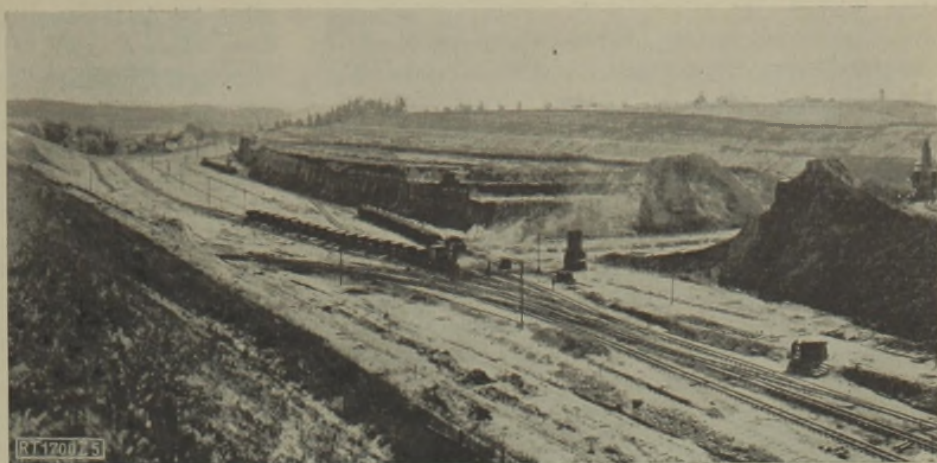
Abb. 5 Einschnitt zwischen Canne und Vroenhoven der Bauarbeiten Kanal Lüttich—Antwerpen (Strecke Haccourt—Briegden)
