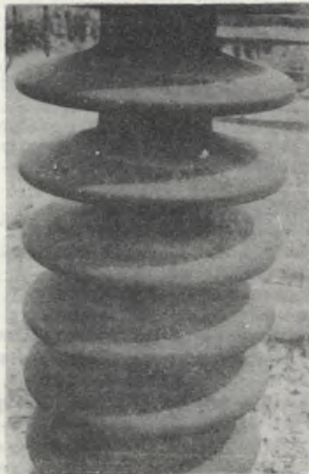
Rys. 2.12. Widok zabrudzonego izolatora w warunkach eksploatacyjnych Fig. 2.12. View of a polluted insulator in operational conditions
