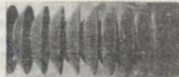
Rys. 2.12. Widok zabrudzonego izolatora w warunkach eksploatacyjnych Fig. 2.12. View of a polluted insulator in operational conditions
