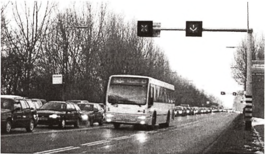
Rys.3. Tymczasowy wydzielony sygnalizacją świetlną pas autobusowy "pod prąd" w Utrechcie Fig.3. Temporary signalling lights separated bus lane under current in Utrecht
