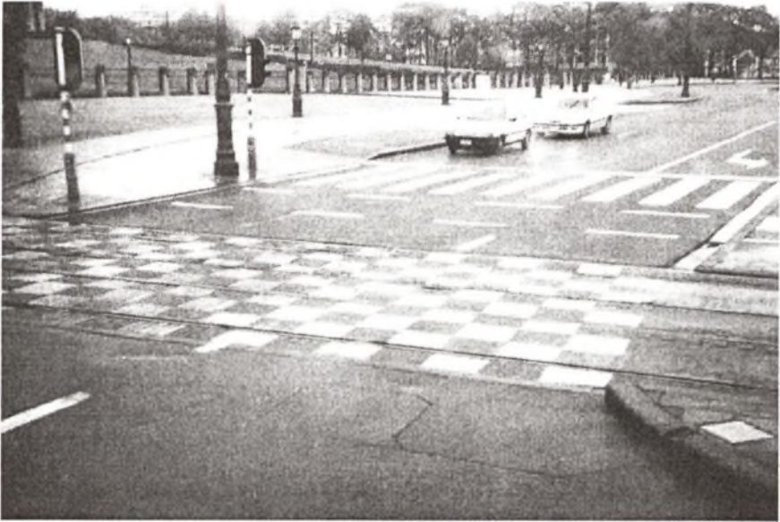
Rys.4. Odmienny sposób oznakowania przejazdu tramwajowego w Brukseli Fig.4. Different marking of tram level crossing in Brussels
