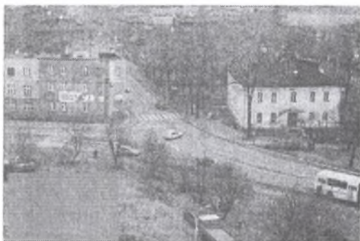
Rys. 4. Skrzyżowanie ulic: Świerczewskiego, Michałkowicka, Parkowa w Siemianowicach Śl., stan przed przebudową w 1999r
