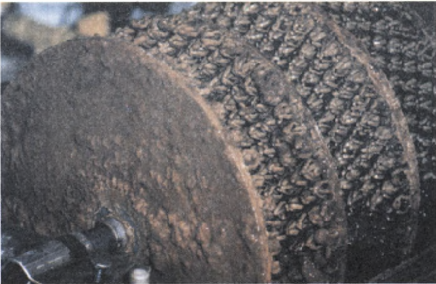
Rys. 7.11. Błona biologiczna na tarczach złoża Fig. 7.11. Biofilm on the contactor disks
