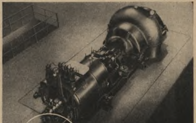
BBC-Dampfurbogebläse, stündl. Leistung 120000 m 3 , 2,1 ata
