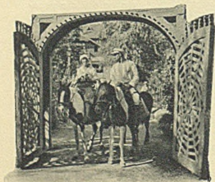
Wjazd do zakładu
