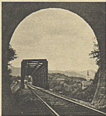
Synowódzko Wyżne — wylot tunelu
