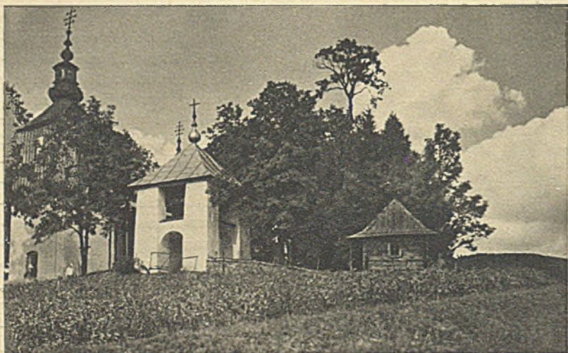
Cerkiew w Balnicy w Bieszczadach
