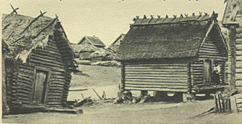
.....z prymitywnej, na palach niegdyś budowanej „kleci“
