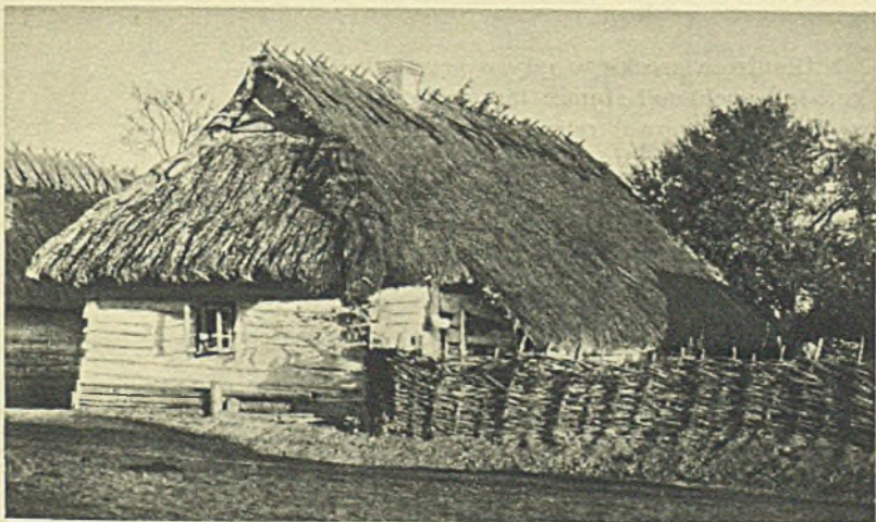
Chata poleska wykazuje cechy pierwotnego budownictwa
