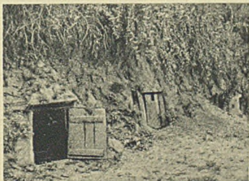
Piwnice wykopane na zboczach loessowych
