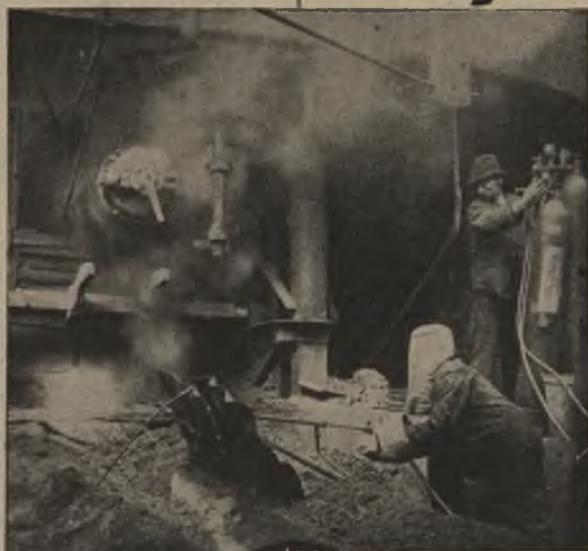
Aus dem ungefügten Brenner zum Aufschmelzen des Hochofen-Stichloches entwickelte zu Anfang des Jahrhunderts
