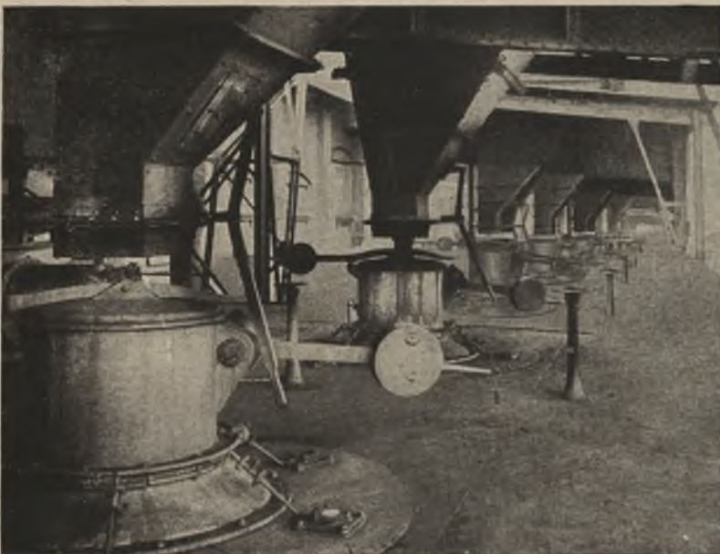
Anlage mit 13 Hilger-Gaserzeugern
