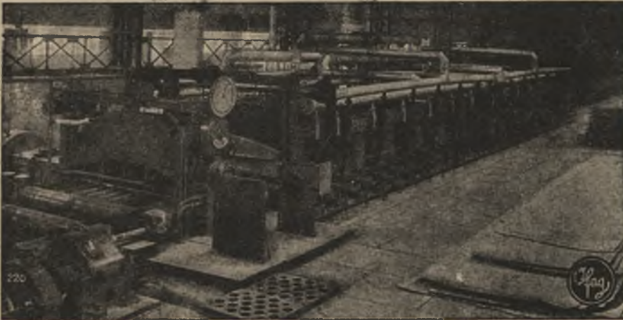
Rollenherdglühen für Mittelbleche. Beheizung durch gereinigtes Generatorgas (Auslaufseite)
