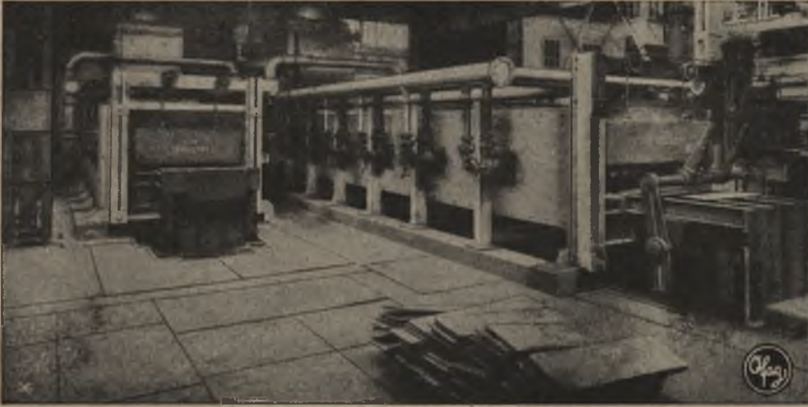
Kontinuierlich arbeitender Platinenwärmofen mit Hubbalkenherd und Auswurfvorrichtung
