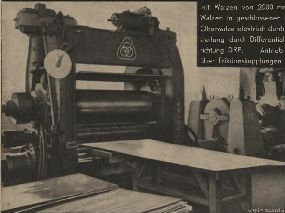
mit Walzen von 2000 mm Ballenlänge, Lagerung der Walzen in geschlossenen Preßstofflagern, Anstellung der Oberwalze elektrisch durch Druckknopfsteuerung, Feinverstellung durch Differentialgetriebe, Präzisions-Zeigervorrichtung DRP. Antrieb der Ober- und Mittelwalzen über Friktionskupplungen.
