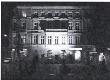
Rys. 11. Kolejny przykład niewłaściwego oświetlenia obiektu
