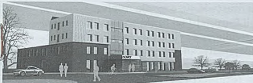
Projekt modernizacji budynku biurowego ISOVER w Gliwicach autorstwa Beaty Szkotak i Mateusza Mindziaka
