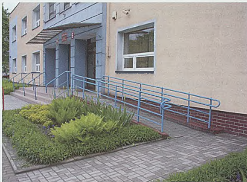
Politechnika Śląska stale dostosowuje się do potrzeb osób niepełnosprawnych, w tym poruszających się na wózkach inwalidzkich. Na zdjęciu wejście do jednego z budynków Wydziału Organizacji i Zarządzania w Zabrze
