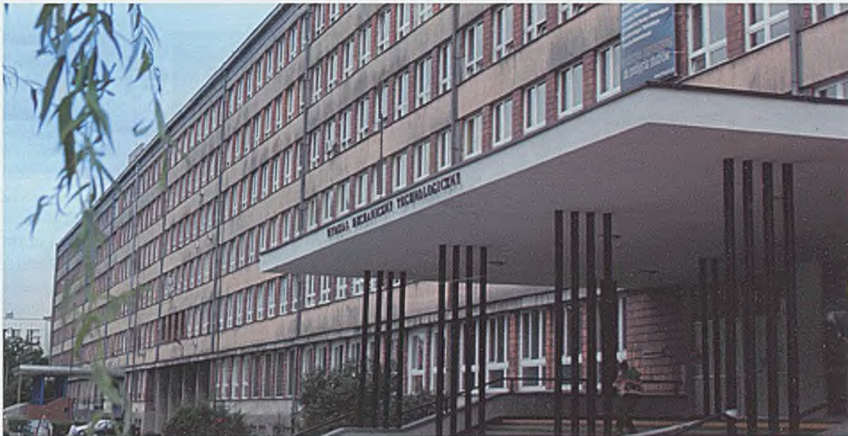
Gmach Wydziału Mechanicznego Technologicznego przy ul. Konarskiego w Gliwicach
