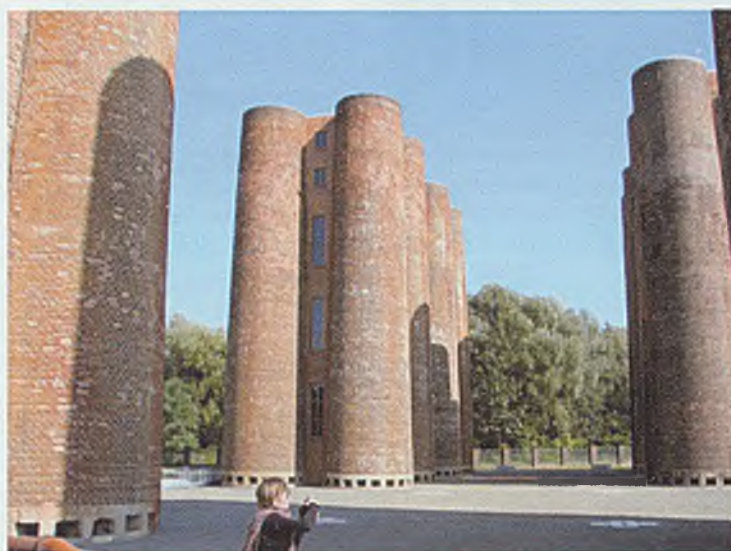
„Bio-wieże”, które jeszcze niedawno służyły do oczyszczania wody w koksowni
