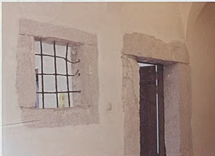
Zachowane kamienne ościeżnice i odrzwia zakrystii wyeksponowane we współczesnym tynku
