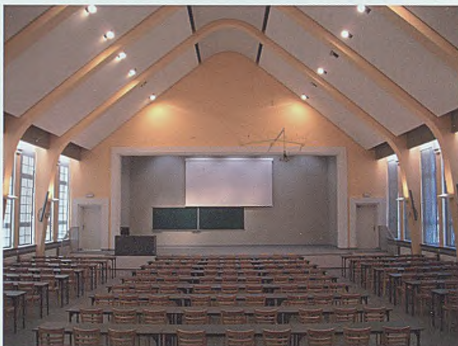
Świeżo wyremontowana sala 302 w budynku C
