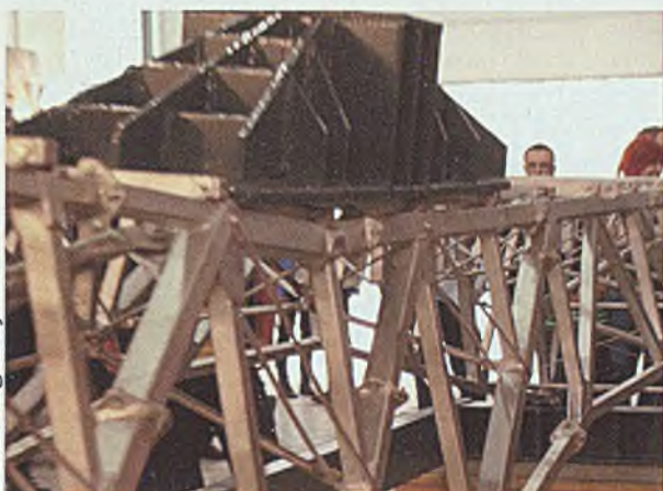
Most w trakcie zniszczenia
